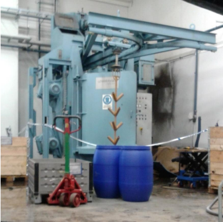
Figur 19 Blästermaskinen där effekterna av explosionen syns på väggen till höger om maskinen.
